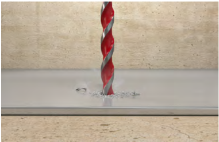
Bohren der Materialkombination Metall und Beton
