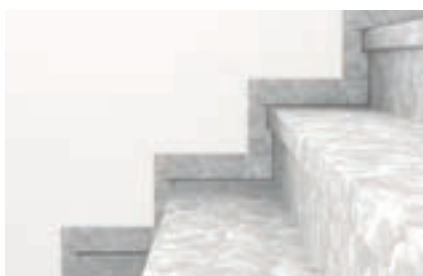
Verfugungen an Natursteinplatten
