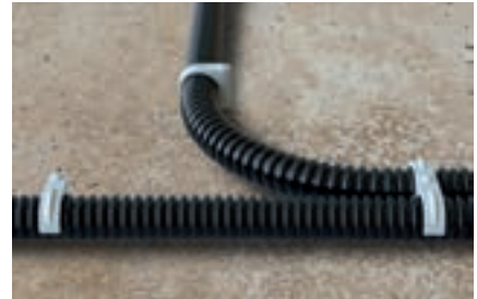
Befestigung flexibler Leerrohre
