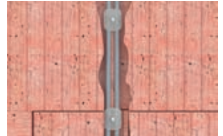
Kabelbefestigung in Schlitzten
