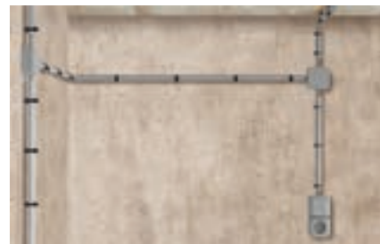
Flexible und starre Kunststoffrohre
