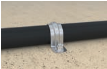
Befestigung von Panzerrohren
