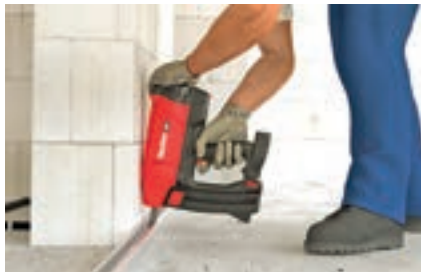
Trockenbau-Schienen
