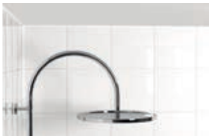
Verfugungen im Sanitärbereich
