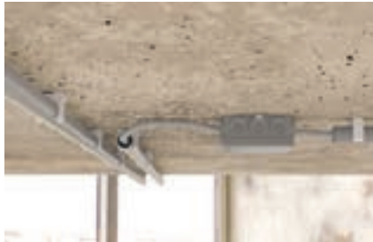
Befestigung von Kunststoff-Isolierrohren
