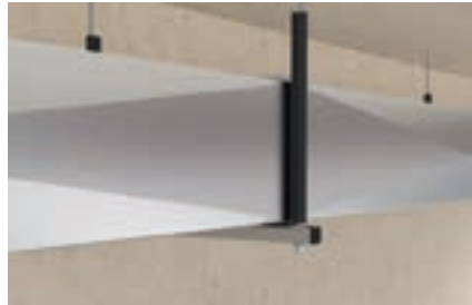
Lüftungskanalfestigung mit Montageschiene
