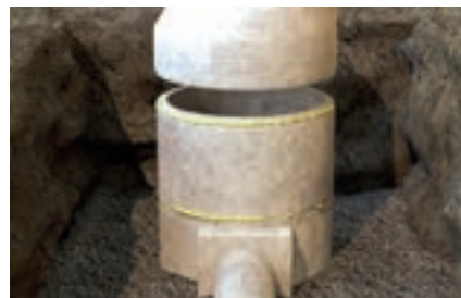
Abdichten von Beton-Schachtringen
