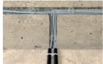
Kabelbefestigung in Wandschlitzten < 55 mm
