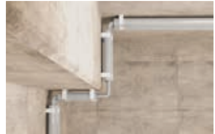
Befestigung von Kunststoff-Isolierrohren
