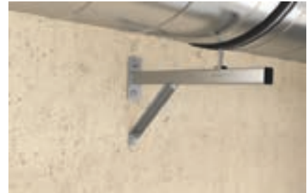
Lüftungsrohrbefestigung an der Wand
